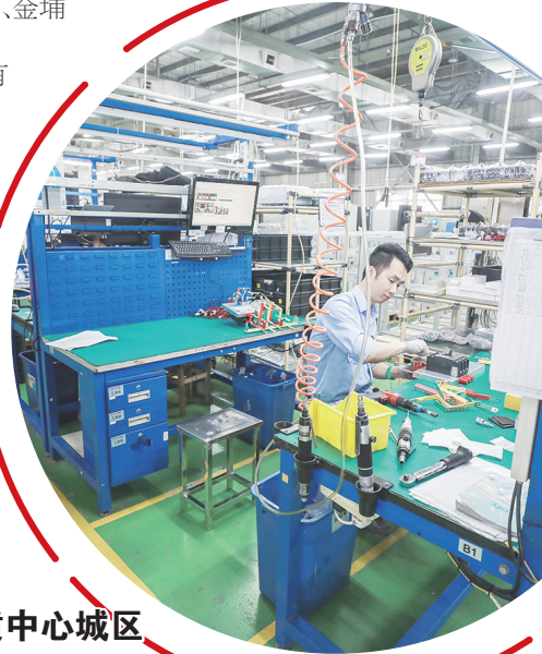
▲科华新建项目车间工人在抓紧装配336V交流屏主机
