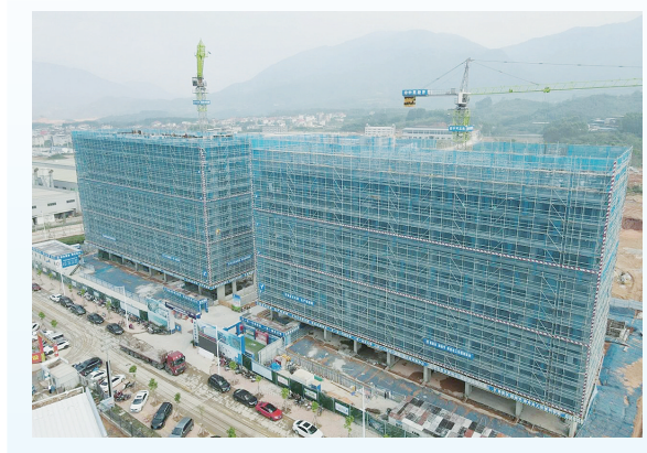
邻里中心项目施工现场航拍
