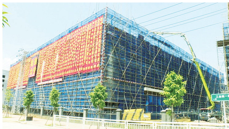
漳州文得立金属制品有限公司厂房顺利封顶
