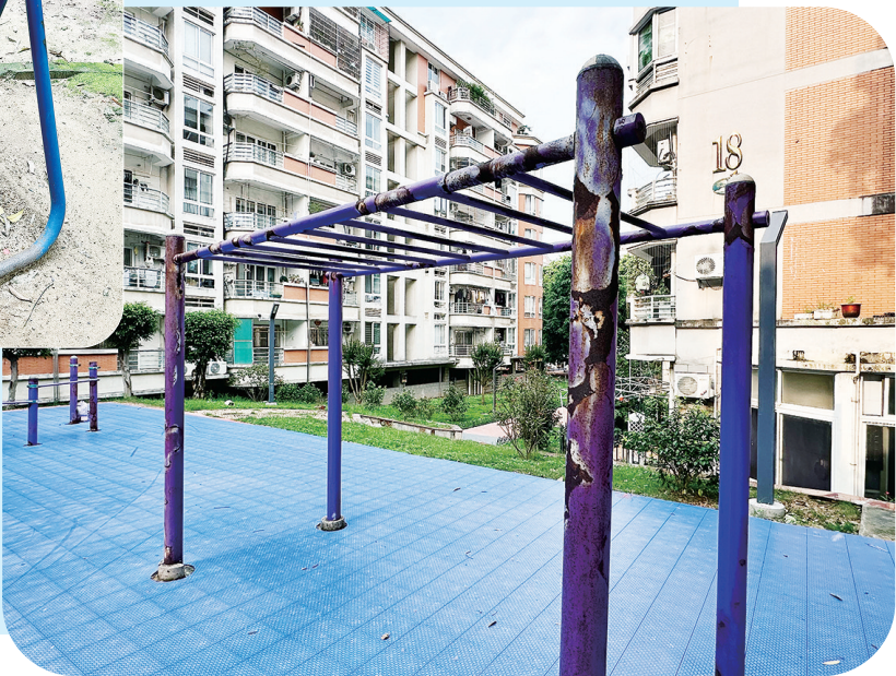
▼华元小区部分公共健身器材锈迹斑斑
