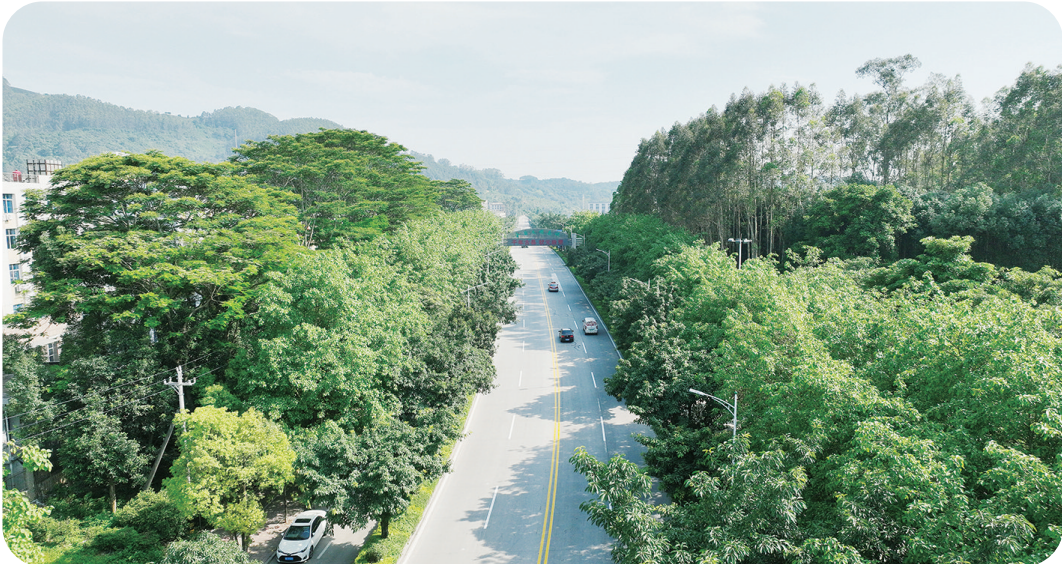
乡道武郭线至郭坑交界处路段养护工程已全面完成
