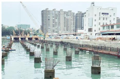
本报讯(欧东苗 李开放 文/图)日前,东山县大澳中心渔港扩建工程正紧锣密鼓开展码头后平台冲孔灌注桩桩基施工(左图),预计7月中旬完成全部桩基浇筑。
