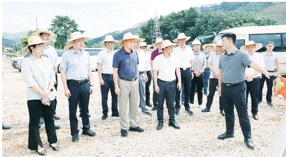
6月26日,漳浦县委书记陈爱棋带队到朝阳水库移民安置小区建设现场了解建设情况,现场协调解决问题。
