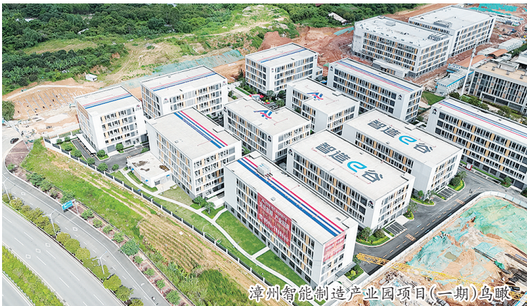
漳州智能制造产业园项目（一期）鸟瞰
