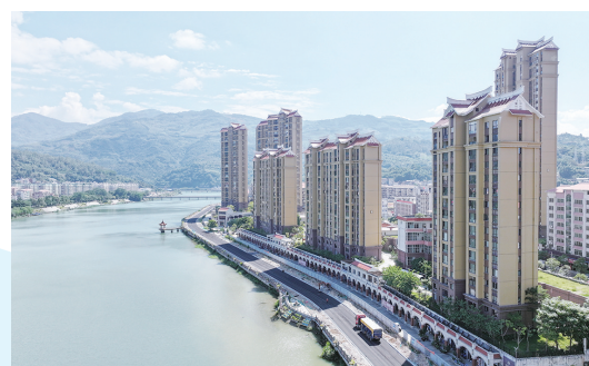
靖河路改造工程项目现场航拍
