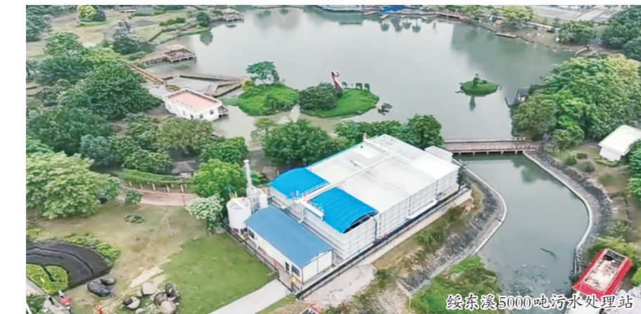
绥东溪5000吨污水处理站
