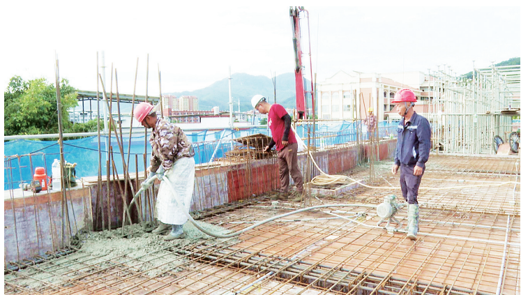
施工人员正在进行混凝土浇筑
