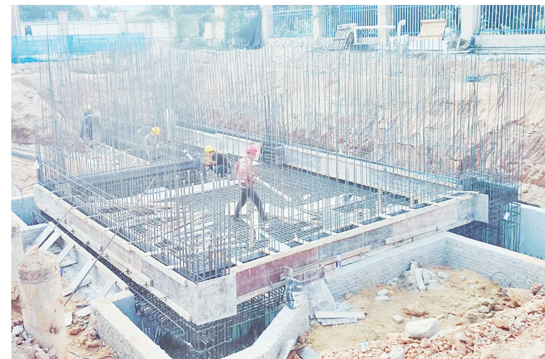
福建鸿叶食品有限公司扩建项目现场
