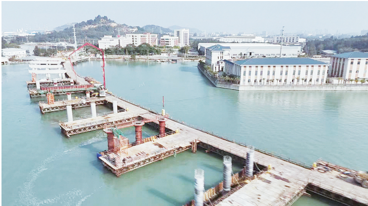
钱岗大桥项目施工现场航拍图
