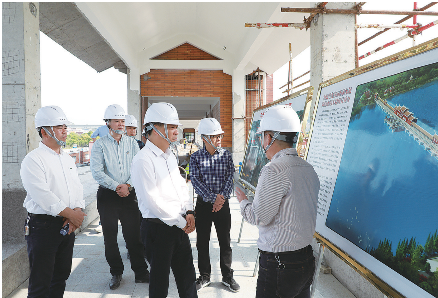
4月7日,龙海区委书记叶毓带队到西溪水闸除险加固工程察看项目建设进度。
