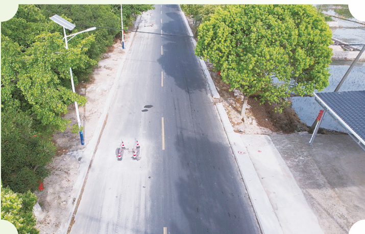
漳东线道路基础设施改造提升工程沙西段建设进入冲刺阶段
