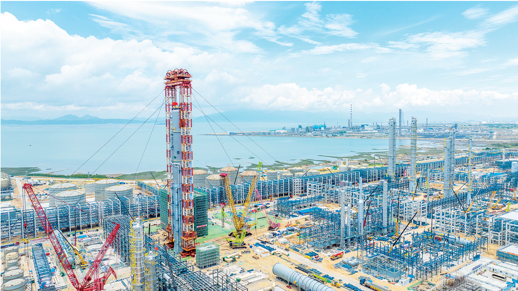
5月16日上午,全球最大EO/EG洗涤塔在福建漳州古雷石化基地成功吊装。
