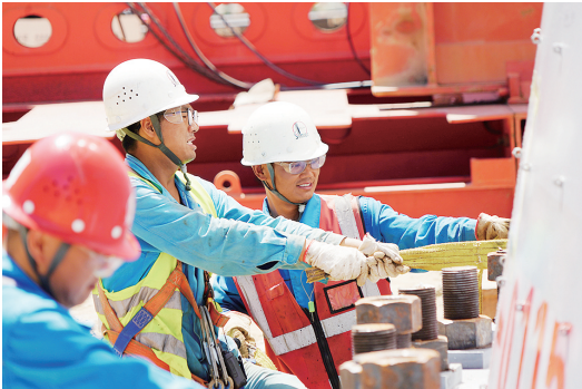
工人正在进行EO/EG洗涤塔的安装找正作业
