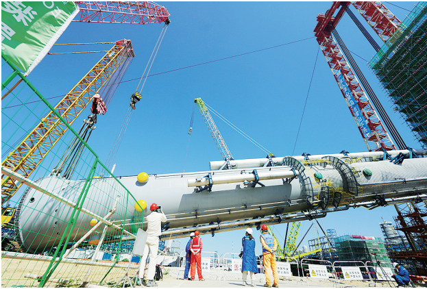
EO/EG洗涤塔缓缓起吊
