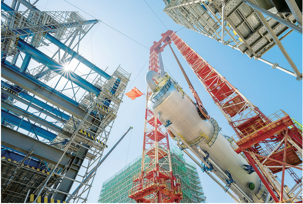
EO/EG洗涤塔吊装中
