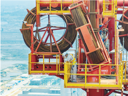
工人在100多米高空观察吊装过程
