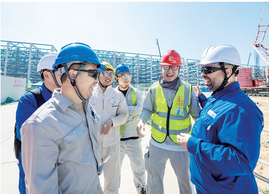
业主方代表与现场施工人员亲切交流
