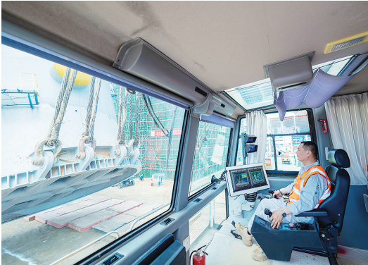
工作人员在2000吨溜尾吊车驾驶室进行吊装操控
