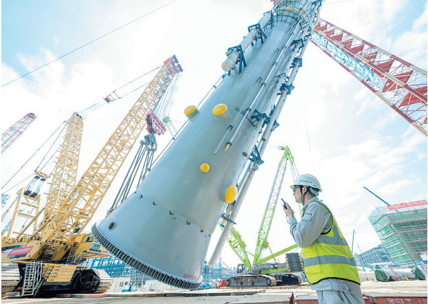
工作人员在吊装现场进行地面指挥
