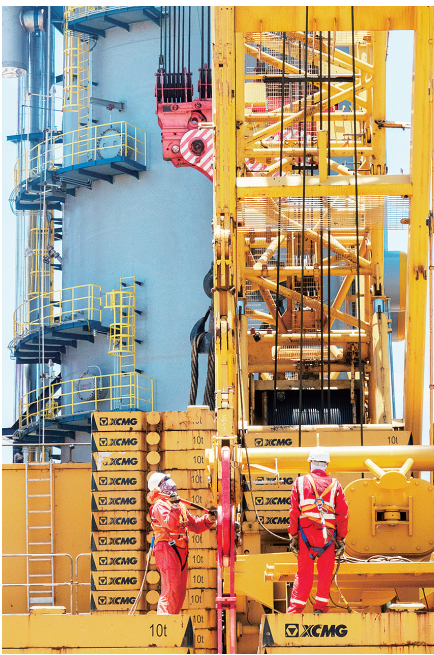
工人在溜尾吊车上实施作业
